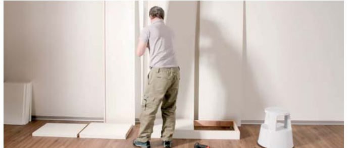
Möbelseite auf Sockel stellen. Durch die vorstehende Schraube ist das Element direkt richtig positioniert.
